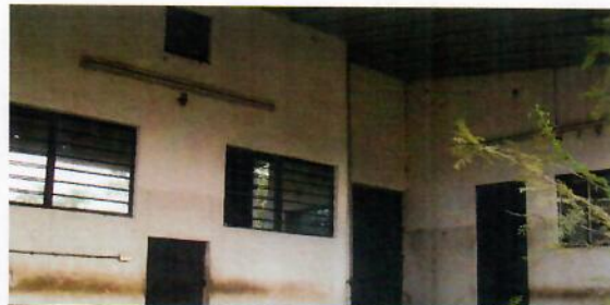
Centro de Acopio Temporal en el municipio de Tomatlán (Próximamente en operación)
